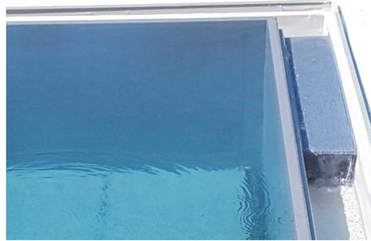
Höhenverstellbar und universell für alle Rekord-Rinnenmodelle einsetzbar und an unterschiedliche Rinnensysteme anpassbar. Standardlängen: 50 cm, 100 cm
